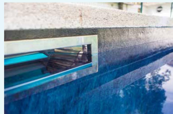
Skimmerbecken erfreuen sich nach wie vor größter Beliebtheit, sie sind einsetzbar bei Einstückbecken und Folienbecken. Wobei der Skimmer die Verbindung zur Filteranlage darstellt. Er ist in die Beckenwand integriert und saugt die Wasseroberfläche ab. Grober Schmutz wie Laub oder Insekten bleiben bereits in seinem Sieb hängen.
