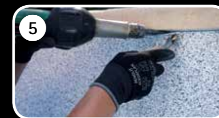
5 Wände mit RENOLIT ALKORPLAN TOUCH auskleiden.
