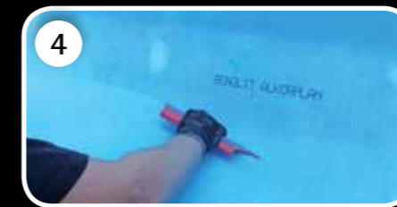
4 RENOLIT ALKORPLAN Vlies anbringen, im Fall von Osmose mit Blasen und Flüssigkeit.
