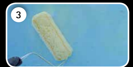
3 RENOLIT ALKORGLUE Kontaktkleber vollflächig auftragen.
